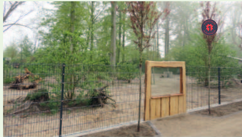
Die Arbeiten an der Anlage für den Roten Panda schreiten voran.
