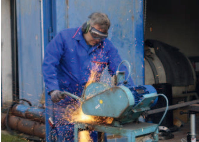
Viele Sanierungsarbeiten konnten von den Mitarbeitern durchgeführt werden.
