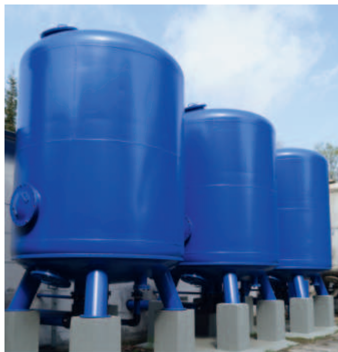
Die frisch lackierten und sanierten Wasserspeicher können jeweils 27.500 Kubikmeter Wasser fassen.
