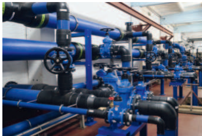
Die Rohre des Wasserwerks wurden im Zuge der Sanierung auf PE-Leitungen (Polyethylen) umgestellt. Foto: René Plückhahn
