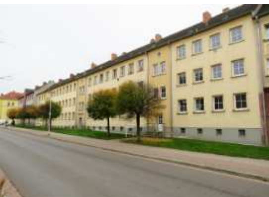
Für die Wohnhäuser in der Stettiner Straße ist eine Sanierung in Planung.
