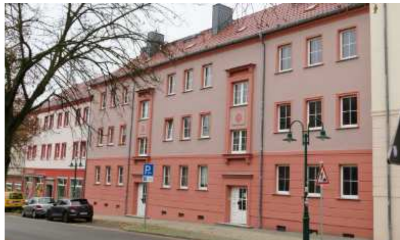
Die nächsten Gebäude in der Marktstraße konnten saniert werden und erstrahlen nun neu. Fotos: Doreen Schmidt
