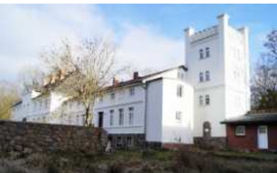
Das Schloss erstrahlt nach umfangreichen Sanierungsarbeiten in neuem Glanz.
