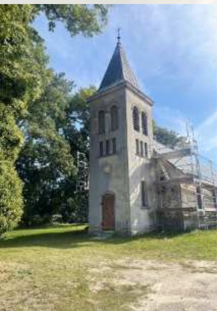
Die Feldsteinkirche wird zurzeit saniert. Fotos: Teresa Mirasch
