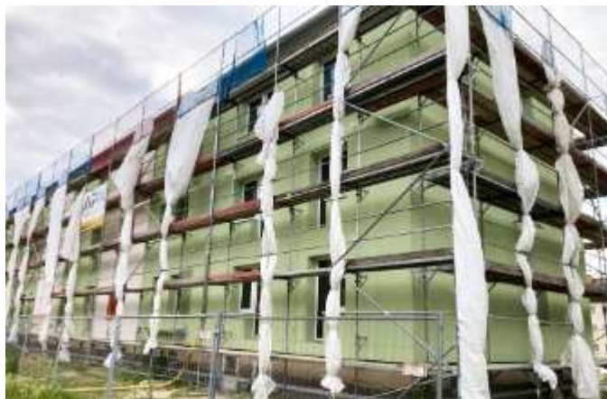
In der Großen Ziegelstraße werden nach der Installation der Balkone die umfangreichen Sanierungsarbeiten abgeschlossen sein.
