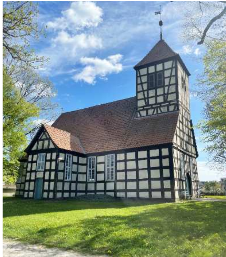
Fachwerkkirche in Luckow
