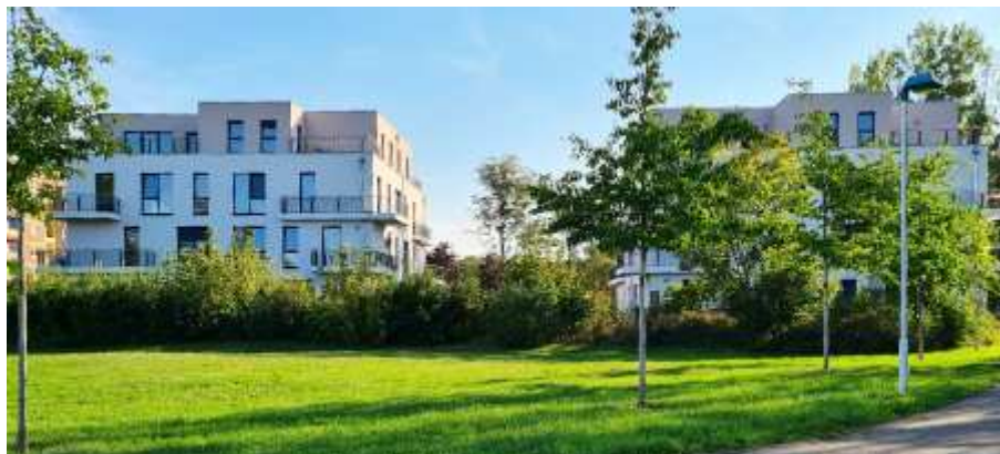
Neubau von zwei Häusern in der Ispenicher Str. 15 im Jahr 2020
