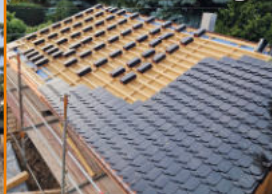
Dacheindeckung & Aufdachdämmung
