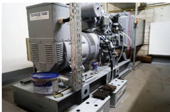
Die Wasserversorgung ist auch bei Stromausfall durch Notstromaggregate gesichert. Fotos: René Plückhahn
