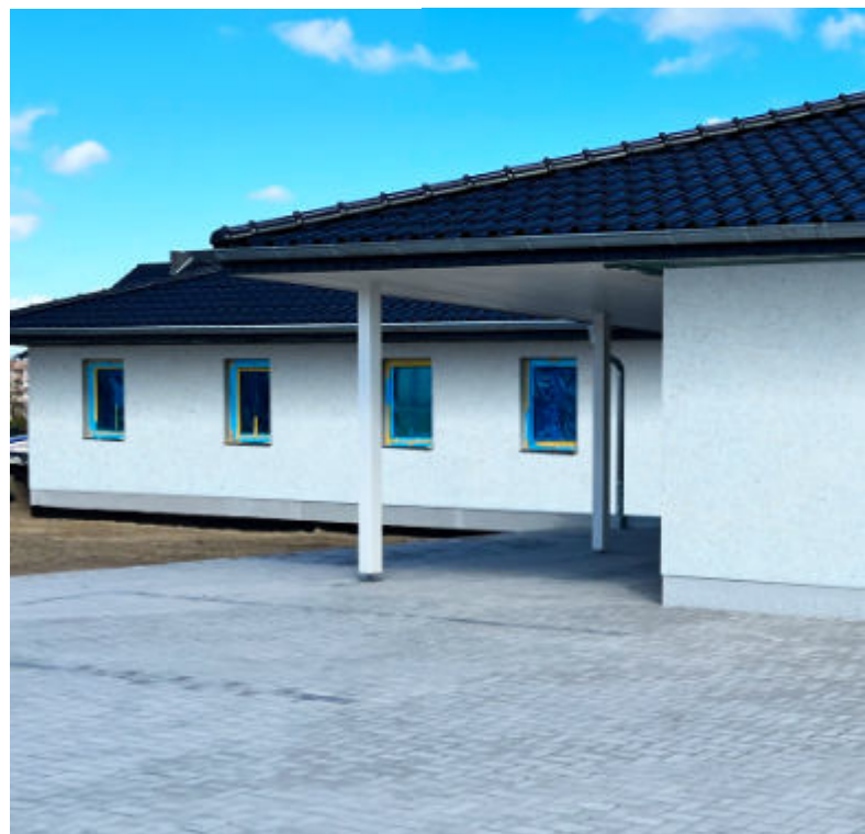
Der Neubau in der Eggesiner Waldstraße 13 kann sich sehen lassen.
